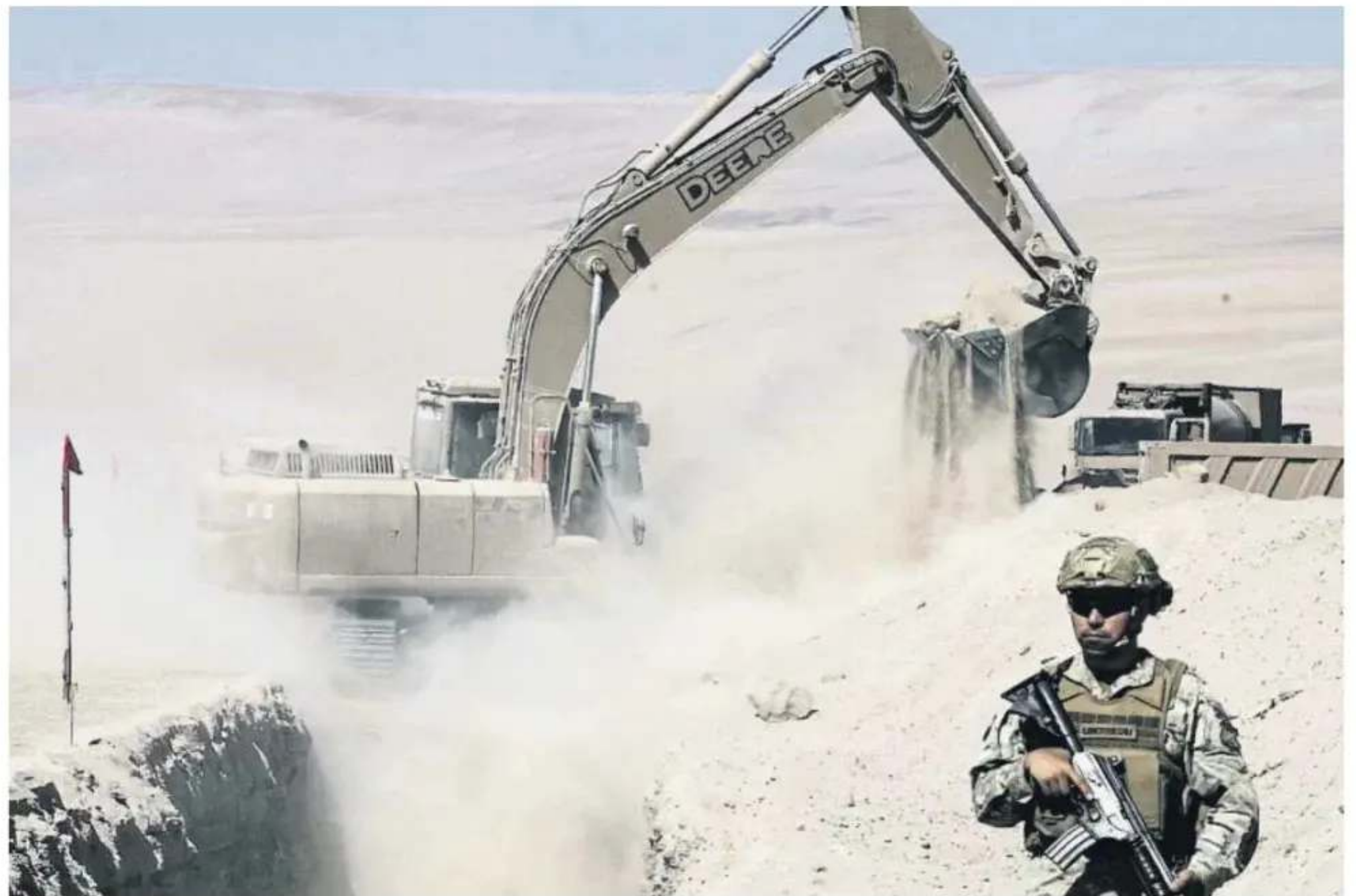
Un soldado controla la zona de Challacuta, cerca de la frontera de Chile con Perú, mientras la maquinaria pesada excava una zanja
